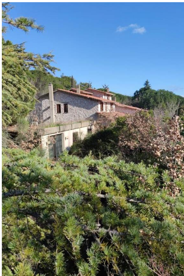
Figura 1.5 stato di conservazione dell'immobile
